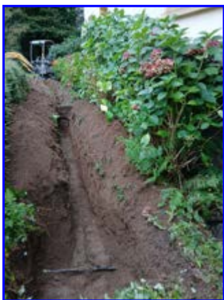
Réparation fuite d'eau
