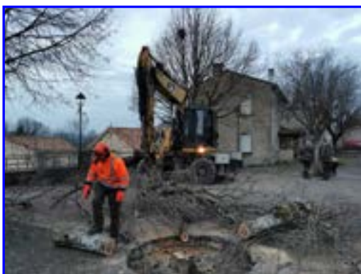
Suppression des arbres, malades ou inadaptés, sur la place avant rénovation.
